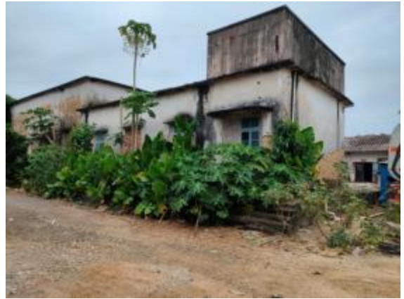
1#生产车间东面/2#生产车间南面：闲置厂房
