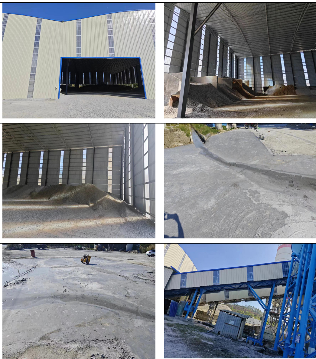
现场整改照片
