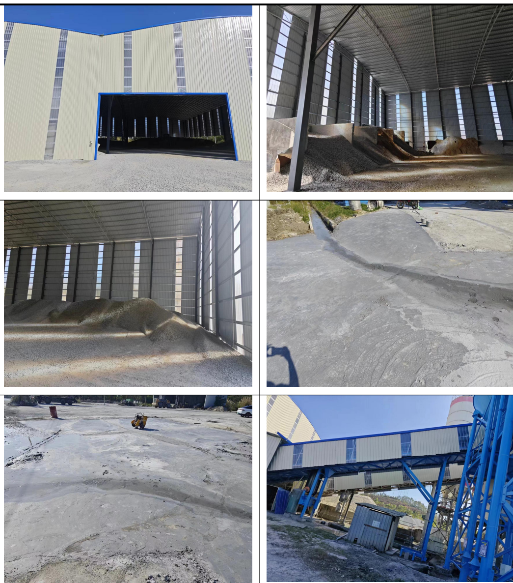
现场整改照片
