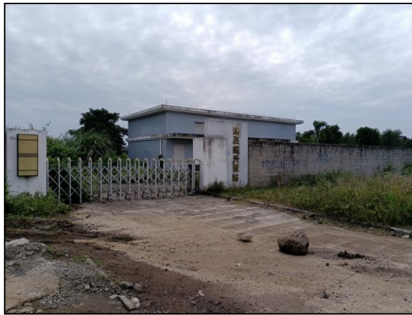
项目北面现状：遂溪提升泵站
