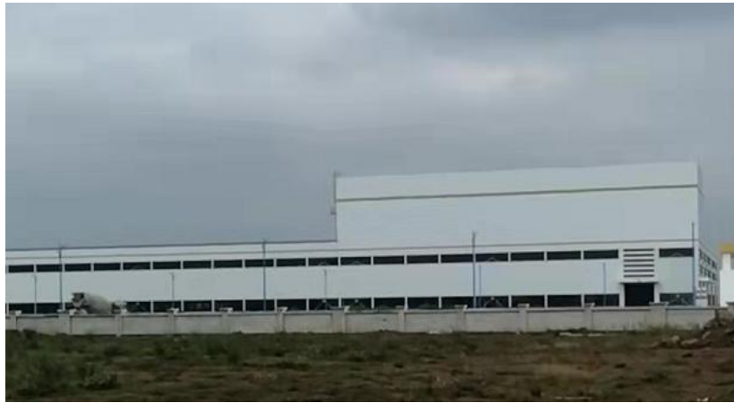
北面为湛江市润阳联合智造有限公司
